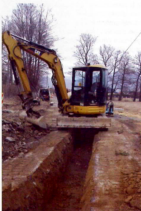
Budowa kanalizacji – ul. Bór w Buczkowicach.
